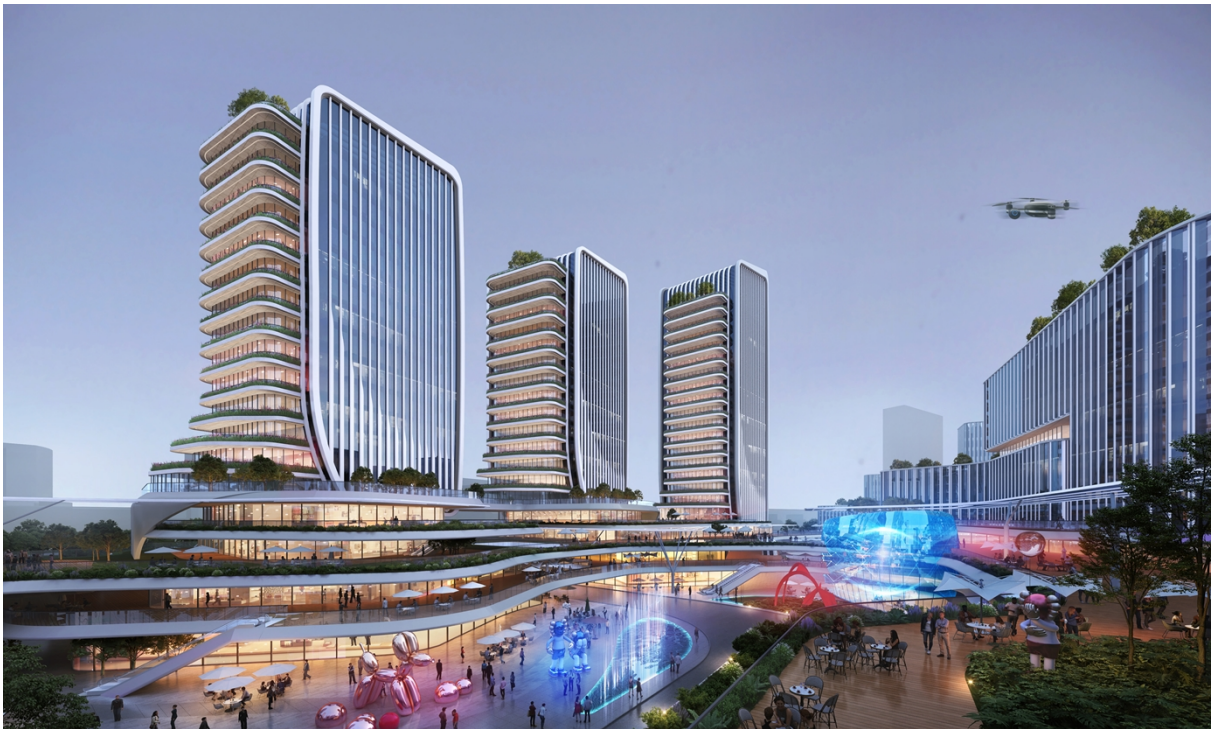
杭州浦沿街道浦联六村联合统筹开发项目
